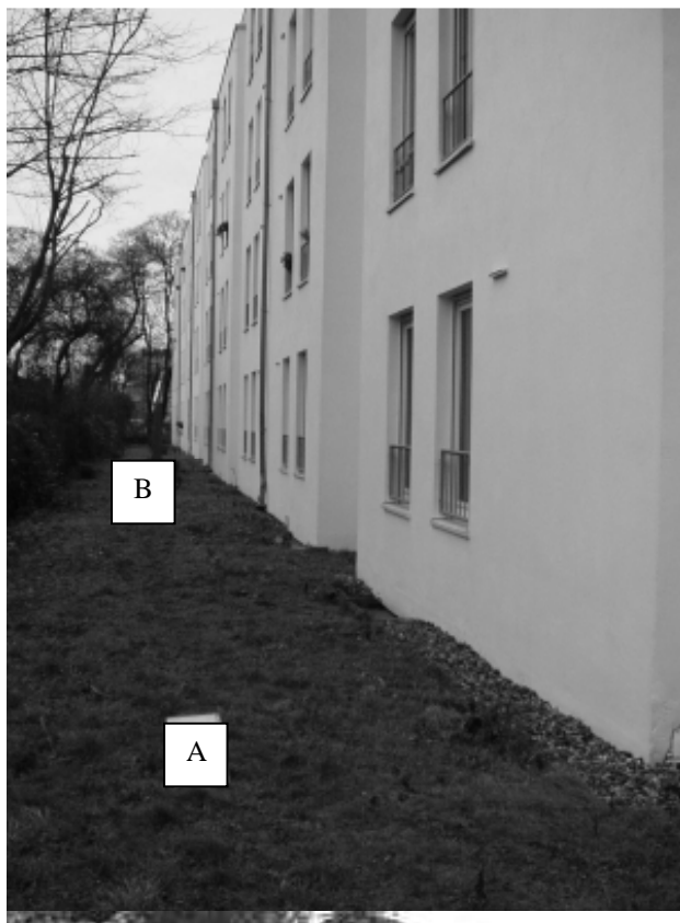
Messort KOEP04_4: MP A/B, 12 m von Gleis 1 (ist)
